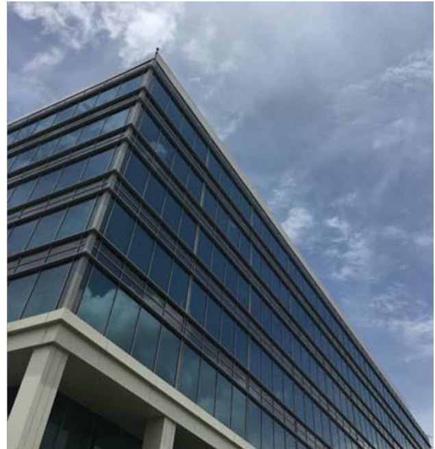
Fig. 1 Fotografía del Centro de Operaciones Banco General.
