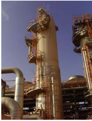
Figure 1 : La colonne d'absorption de In Salah Gas (ISG)
